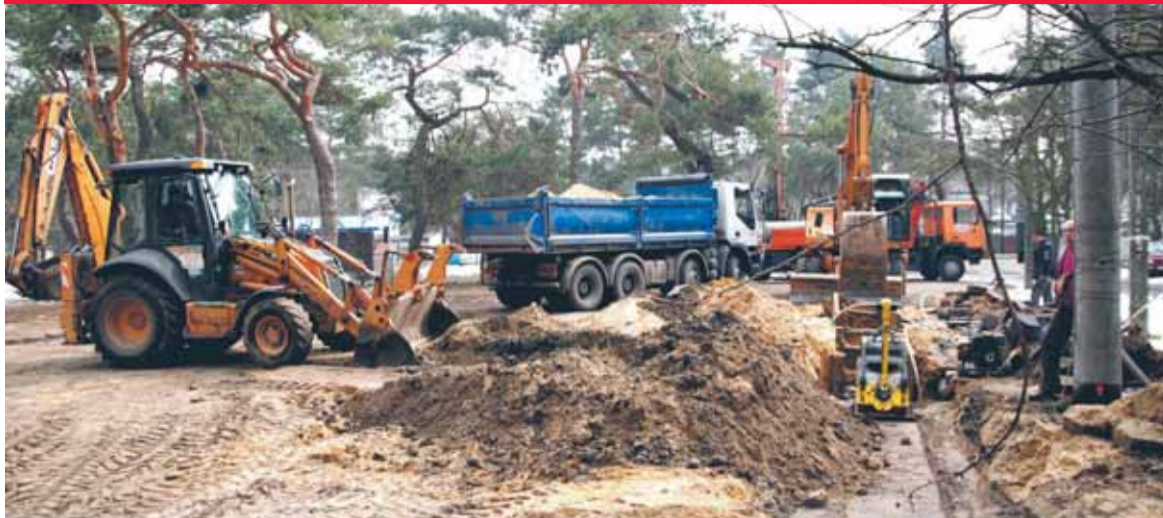
Budowa kanalizacji w ulicy Plażowej
